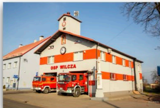
Ogólnopolski program finansowania służb ratowniczych, część 3 – Modernizacja energetyczna budynków OSP
